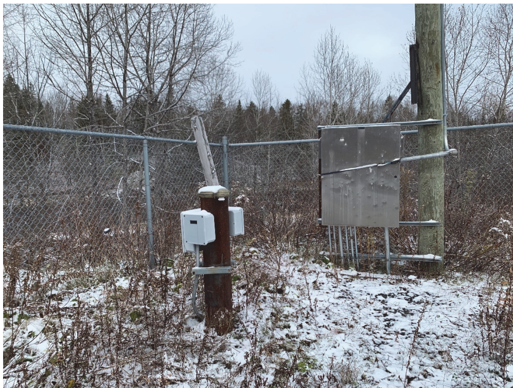
Photo 1 : Aperçu du puits P-1 - 2020-10-26
