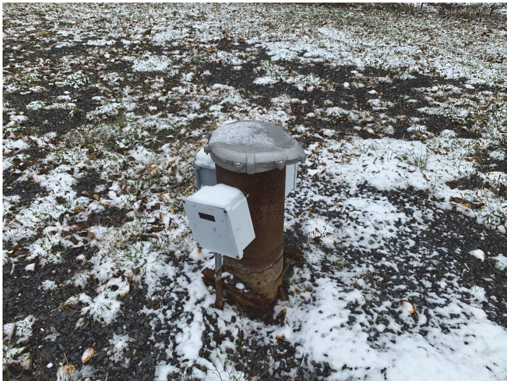
Photo 3 : Aperçu du puits P-3 - 2020-10-26
