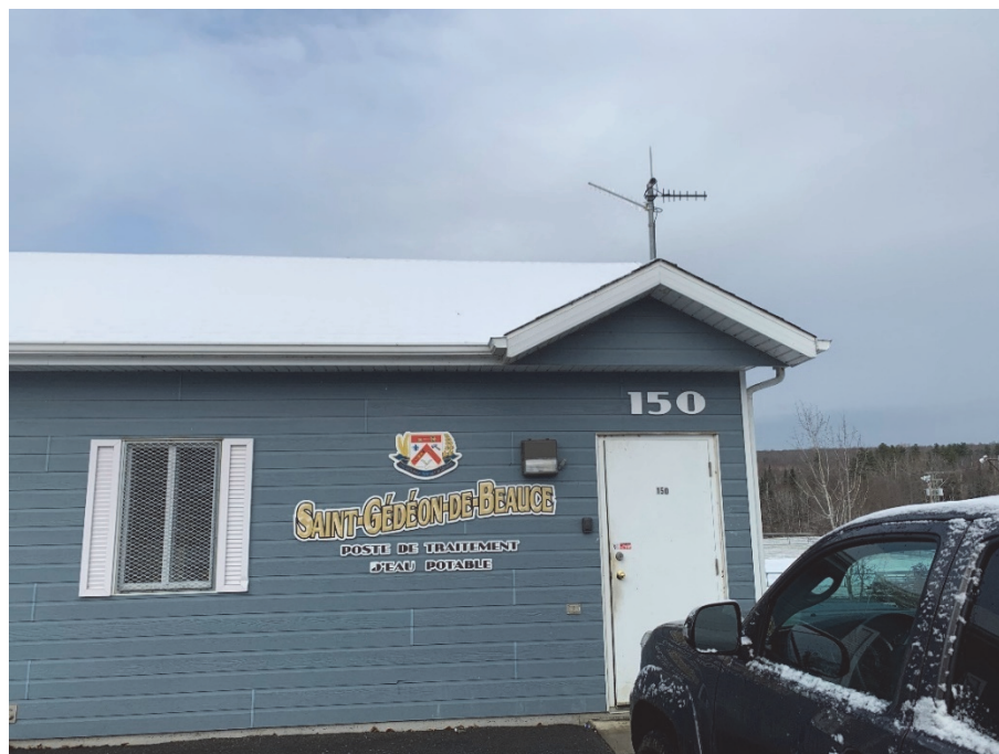
Photo 4 : Aperçu du bâtiment de production d'eau potable – 2020-10-26
