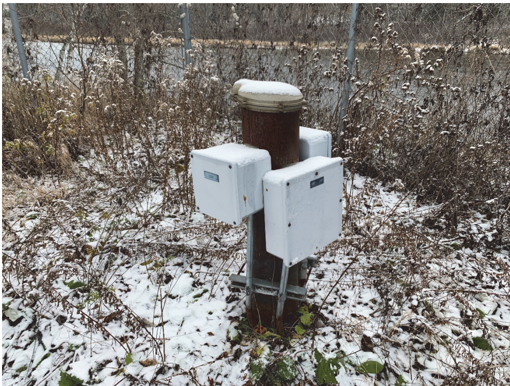
Photo 2 : Aperçu du puits P-2 - 2020-10-26
